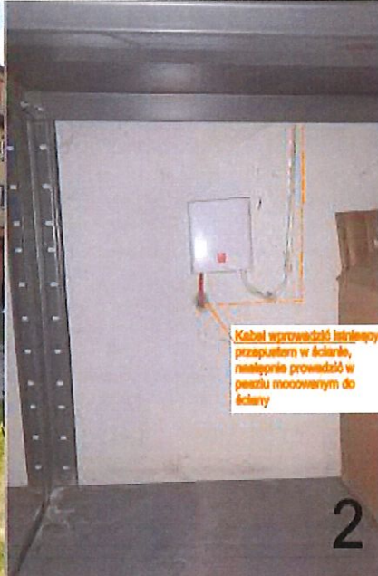
Doprowadzić kabel światłowodowy do budynku
